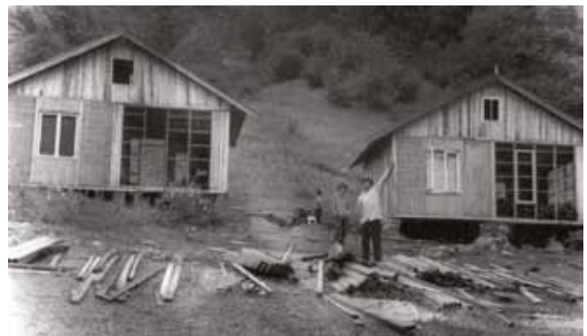
Строительство учебно-научной базы Чечено-Ингушского университета
